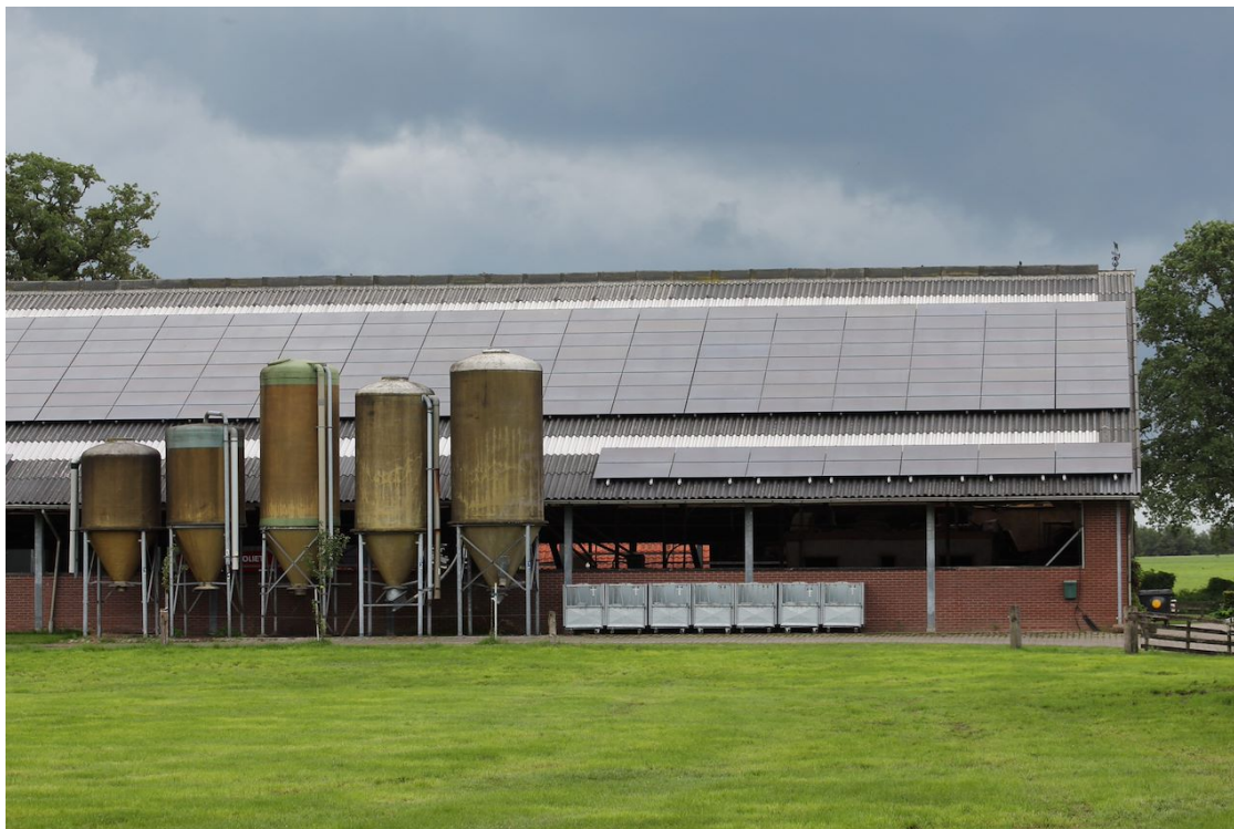
Zonnepanelen melkveebedrijf Ambt Delden
